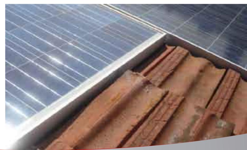
*Esempio di impianto in totale integrazione con l'uso di canaline di scolo e scossaline di raccordo*
